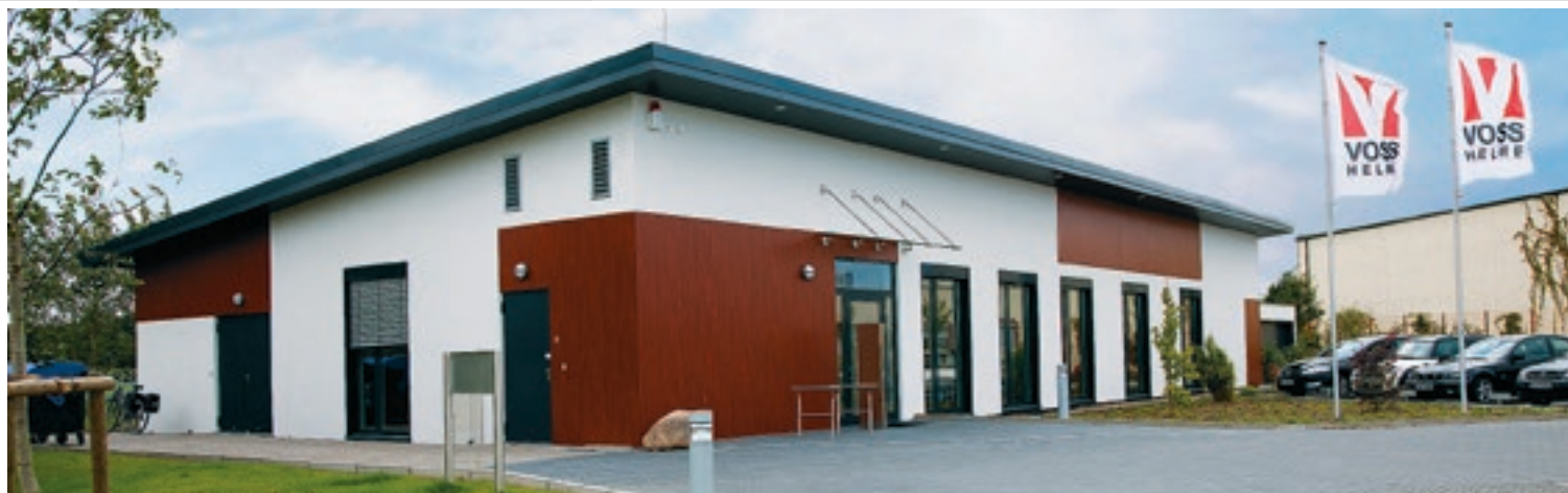
Unser Verwaltungsgebäude – ein modernes Plus-Energie-Haus
